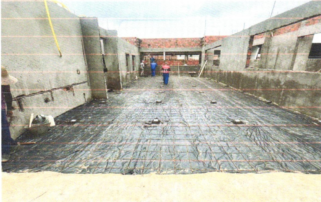
FOTO 52 – Contrapiso de concreto não-estrutural, espessura 3cm e preparo
