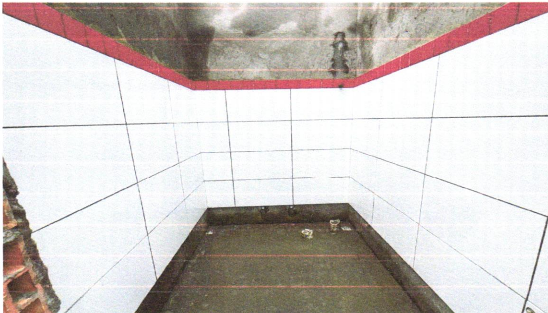
FOTO 39 – REGISTRO DE GAVETA BRUTO, LATÃO, ROSCÁVEL, 3/4", COM ACABAMENTO E CANOPLA CROMADOS - FORNECIMENTO E INSTALAÇÃO. AF_08/2021
