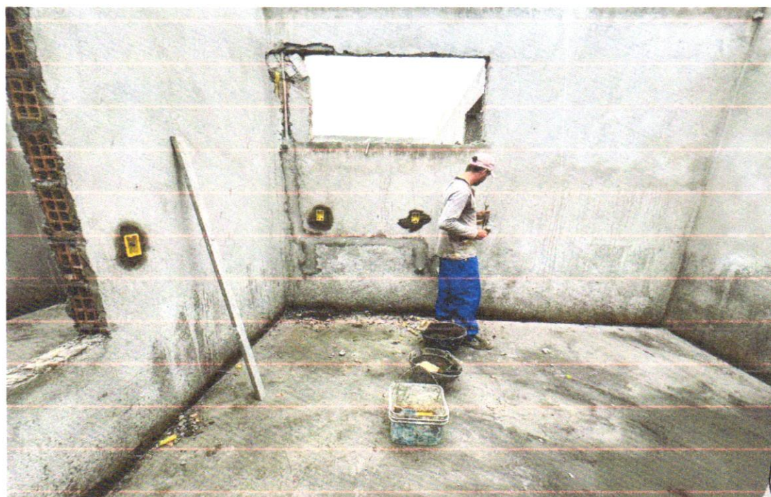
FOTO 46 – Eletroduto PVC flexível 3/4", inclusive conexões conexões
