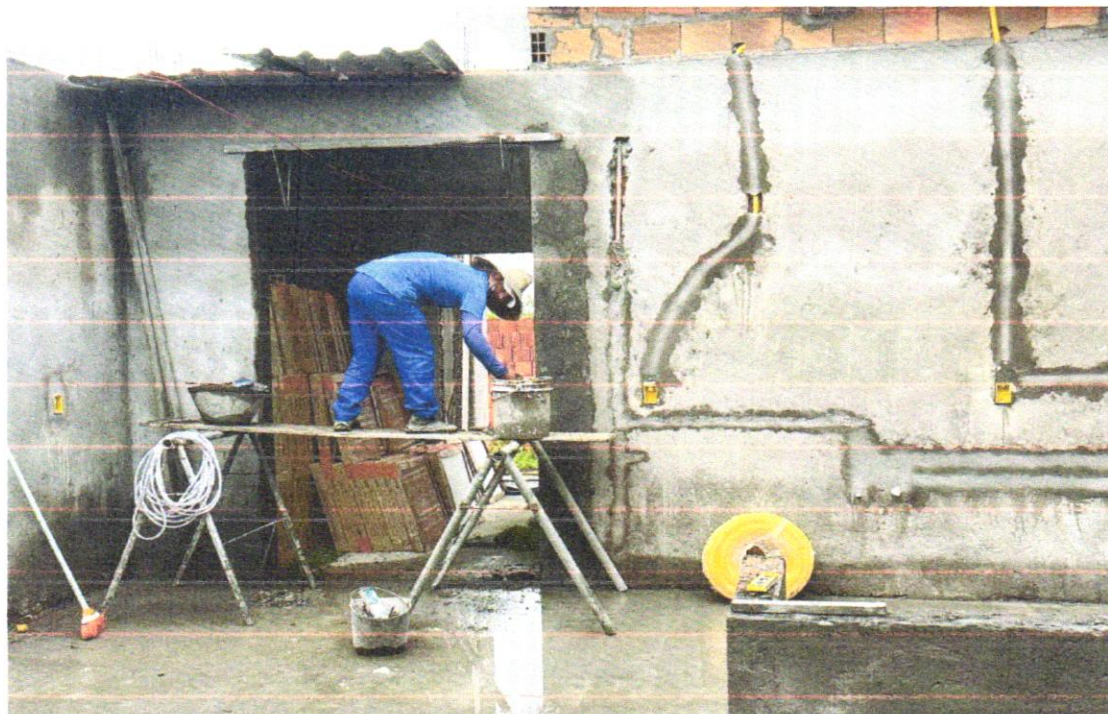
FOTO 46 – Eletroduto PVC flexível 3/4", inclusive conexões conexões
