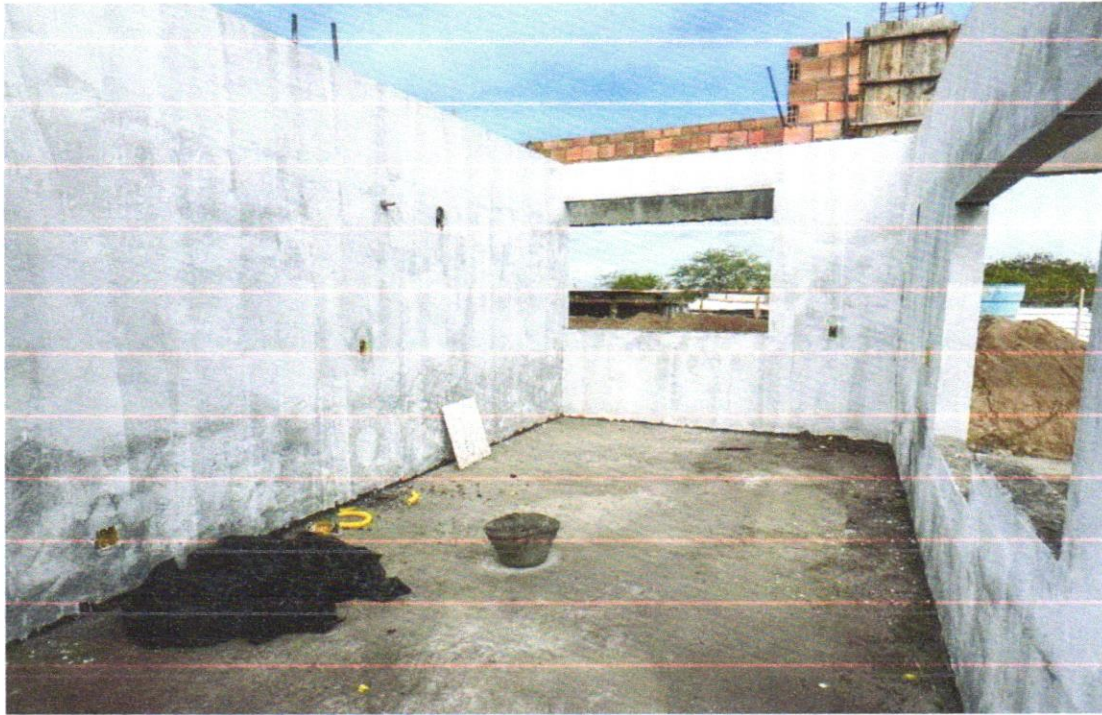
FOTO 38 – Pintura em látex acrílico sobre paredes internas e externas, 2 demãos
