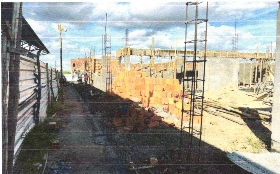
FOTO 08 – Armação de aço CA-50 Ø 8mm; incluso fornecimento, corte, dobra e colocação
