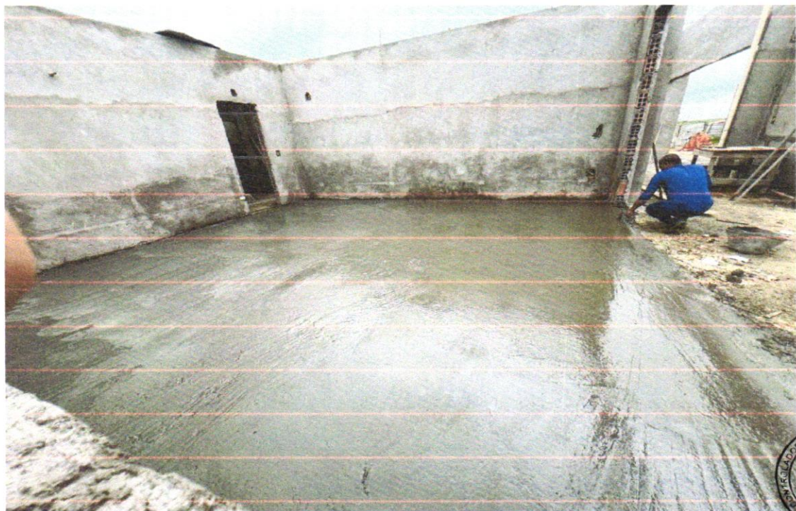
FOTO 52 – Contrapiso de concreto não-estrutural, espessura 3cm e preparo
