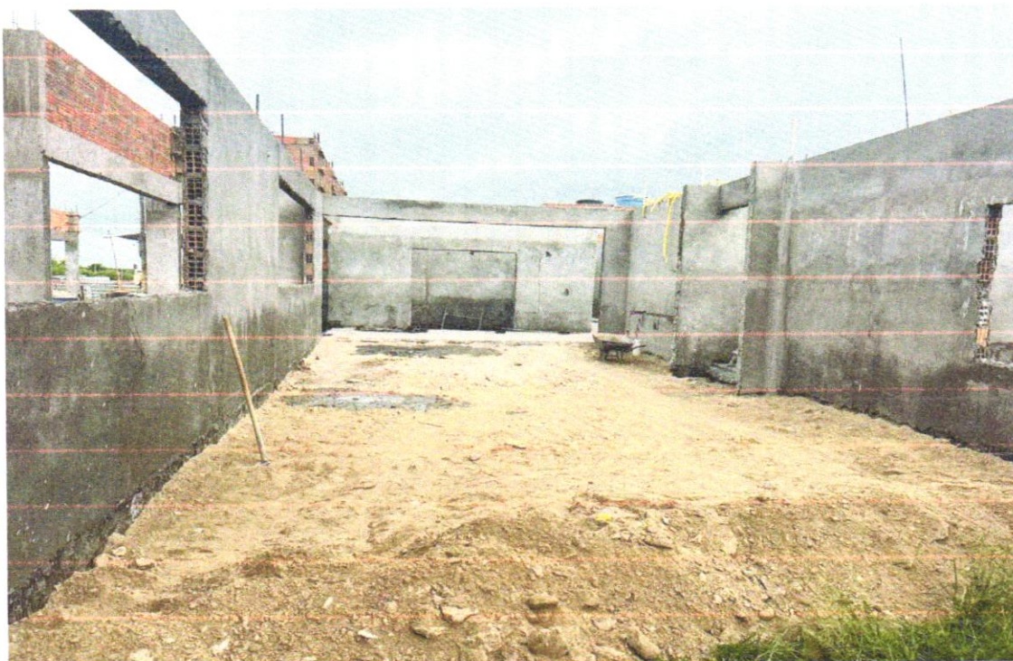
FOTO 06 – ATERRO MANUAL DE VALAS COM SOLO ARGILO-ARENOSO E COMPACTAÇÃO MECANIZADA. AF_05/2016
