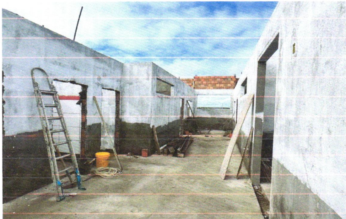
FOTO 38 – Pintura em látex acrílico sobre paredes internas e externas, 2 demãos
