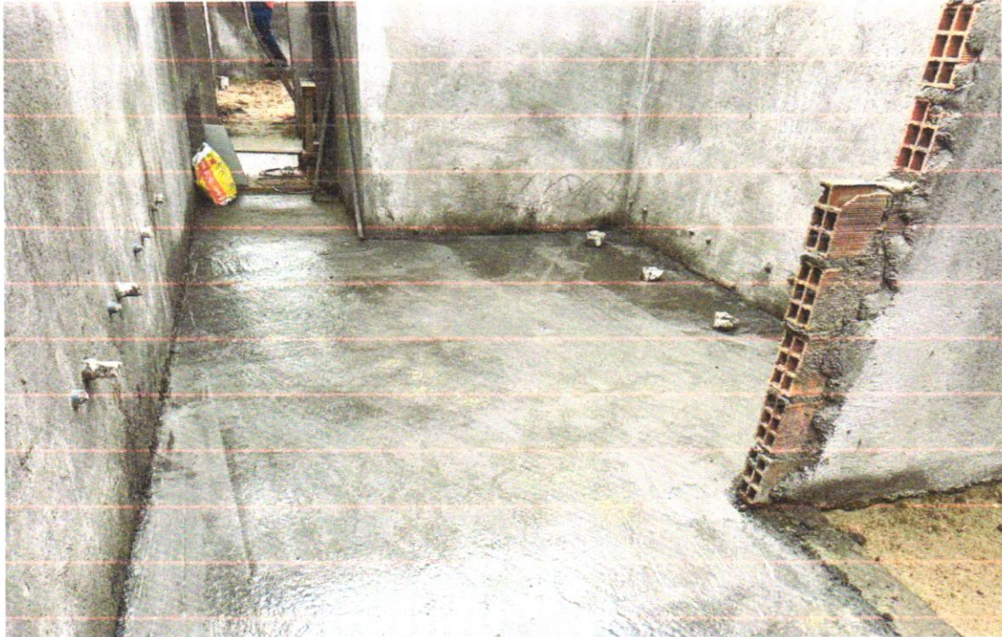
FOTO 54 – Camada regularizadora traço 1:4 (cimento e areia) espessura 2cm
