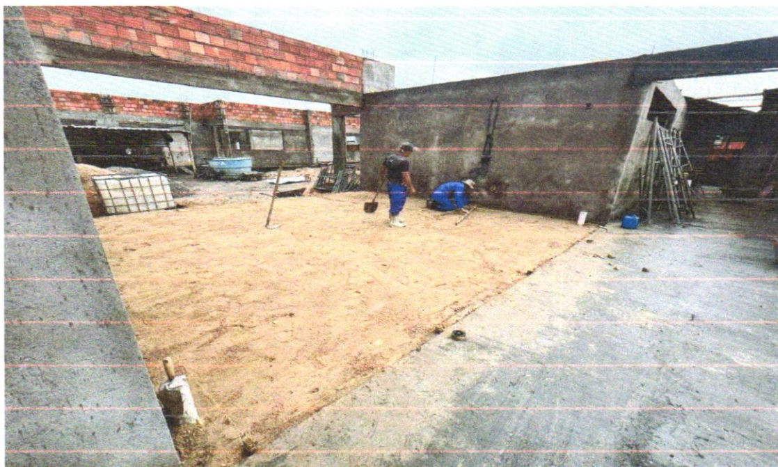
FOTO 02 - ATERRO MANUAL DE VALAS COM SOLO ARGILO-ARENOSO E COMPACTAÇÃO MECANIZADA. AF_05/2016
