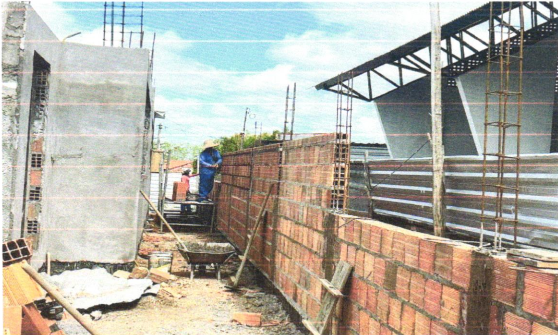
FOTO 08 – Armação de aço CA-50 Ø 8mm; incluso fornecimento, corte, dobra e colocação
