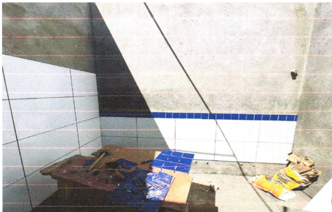
FOTO 40 – REGISTRO DE GAVETA BRUTO, LATÃO, ROSCÁVEL, 3" - FORNECIMENTO E INSTALAÇÃO. AF_08/2021
