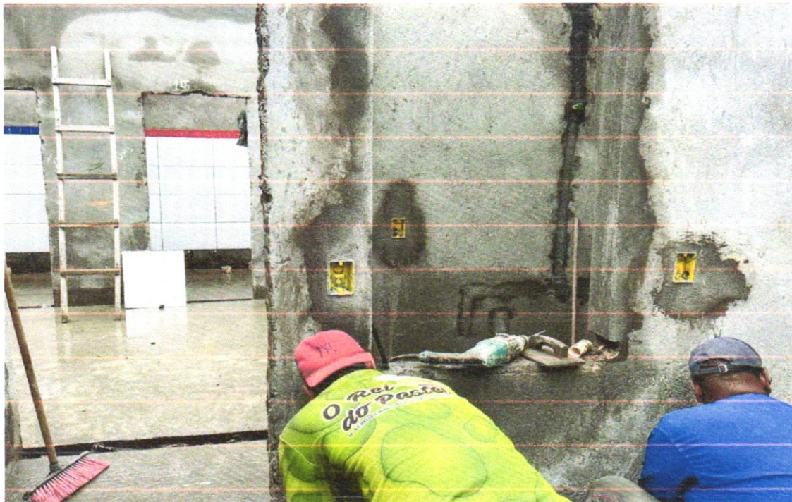
FOTO 44 – Caixa de passagem PVC 4x2"
