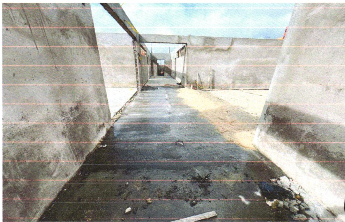
FOTO 54 – Camada regularizadora traço 1:4 (cimento e areia) espessura 2cm
